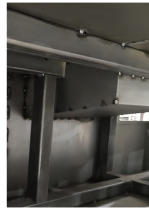
Estructura interna reforzada
